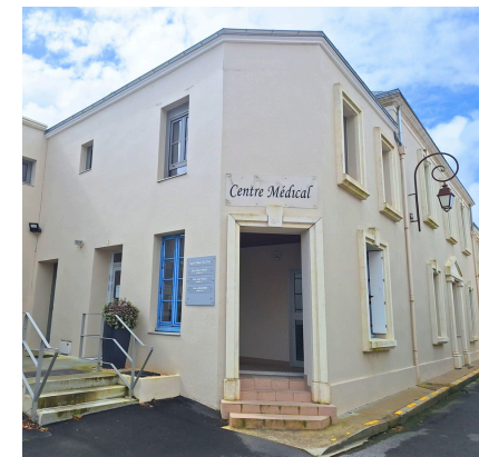
Cabinet de Beauvoir-Sur-Mer
